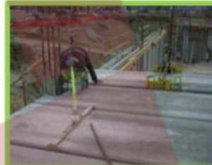
Draag persoonlijke valbeveiliging bij het plaatsen van breedplaatvloeren of welfsels. Voor breedplaatvloeren bestaan geïntegreerde leuningsystemen voor een veilige plaatsing..
