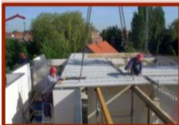
Valgevaar bij het plaatsen van breedplaat vloeren of welfsels.
