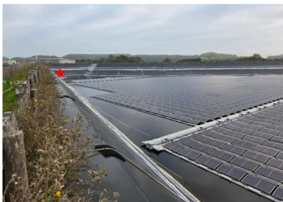
Foto 1 – Binnenkant van het waterbekken, gefotografeerd vanop de berm. Vanop de berm is het bekken ca. 9 m diep. Het te herstellen deel bevindt zich ter hoogte van de rode ster. Let op de drijvende zonnepanelen op het bekken.
