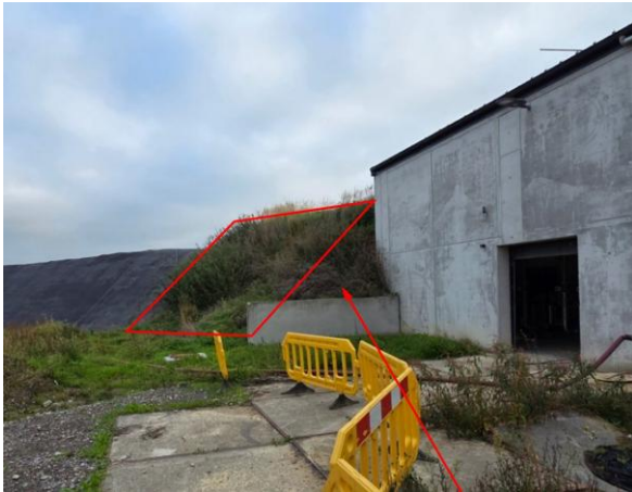
Foto 3 – Deel van de berm dat vanaf de buitenkant wordt weggehaald.
