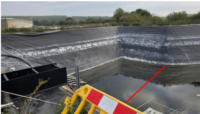
Foto 5 – Ter hoogte van de rode lijn worden in het bekken big bags gevuld met zand geplaatst om de werkzone af te scheiden van de rest van het bekken en volledig droog te zetten.
